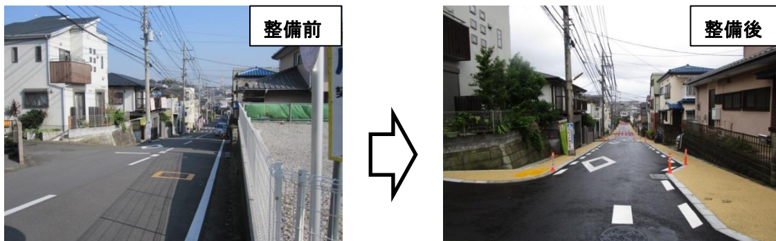
神奈川県綾瀬市寺尾釜田地区 市道 635 号線 シケイン
